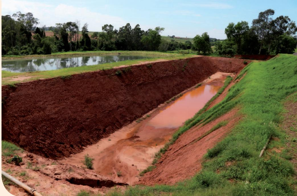
mento de Efluentes), composto por uma lagoa acidogênica e um biodigestor com algumas particularidades e diferente em relação ao modelo atual. O novo tem agitação hidráulica, distribuição do material de forma diferente, recirculação automatizada e impermeabilização de fundo com geomembranas. Nossa expectativa é que gere uma produtividade de biogás um pouco maior e ainda ofereça mais segurança para o processo”, diz o gerente industrial.
